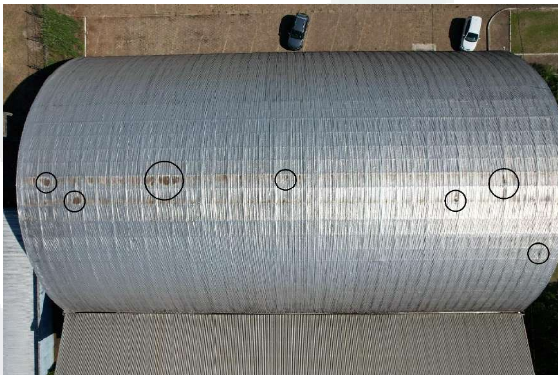
Imagem 23- Vista superior da cobertura
