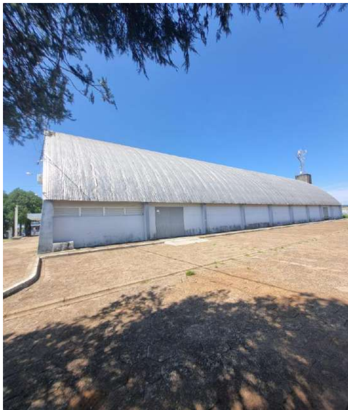
Imagem 7- Vista da lateral direita do edifício
