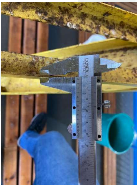
Imagem 12- Aferição de espessura na diagonal da treliça principal
