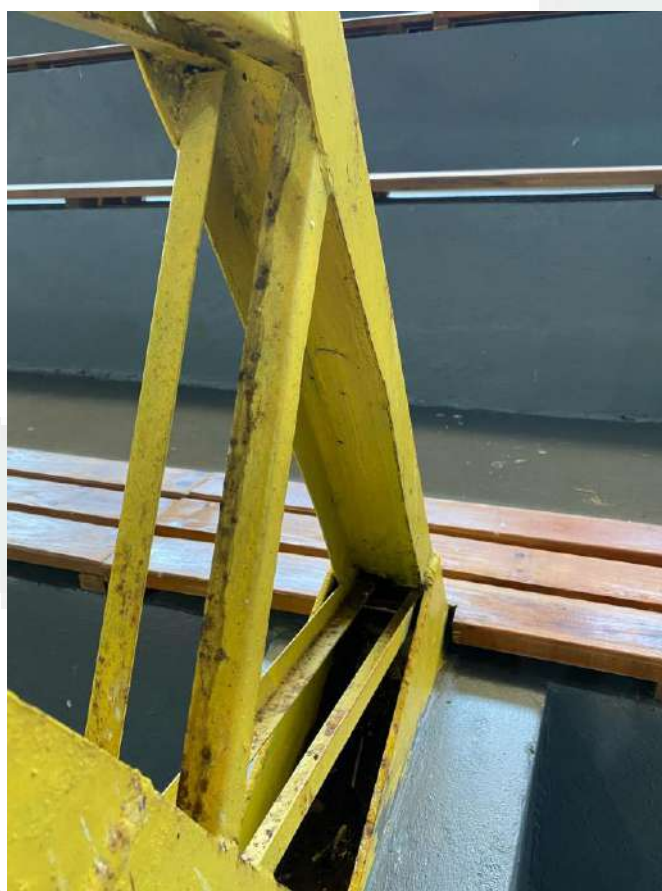
Imagem 10- Apoio da treliça principal em pilar
