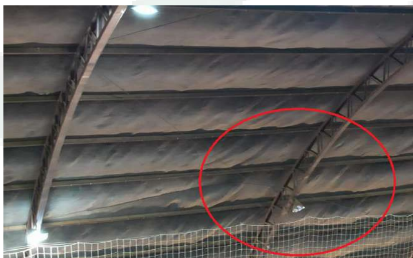
Imagem 28 - Contraventamento rompido
