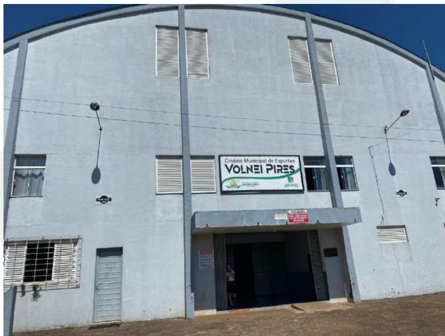
Imagem 4- Vista do acesso principal da edificação
