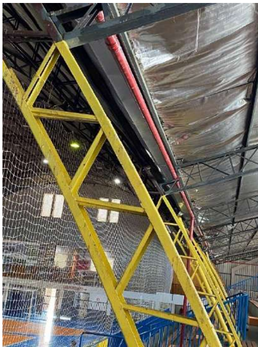
Imagem 11- Junção entre treliça principal e treliça inclinada
